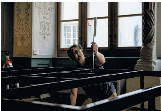
Aufbau der neuen Dauerausstellung
